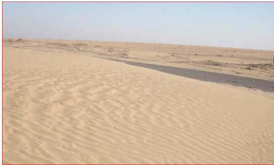
صورة (1) زحف الرمال على طريق بيجي- صينية التقطت الصورة بتاريخ 2018/6/17
