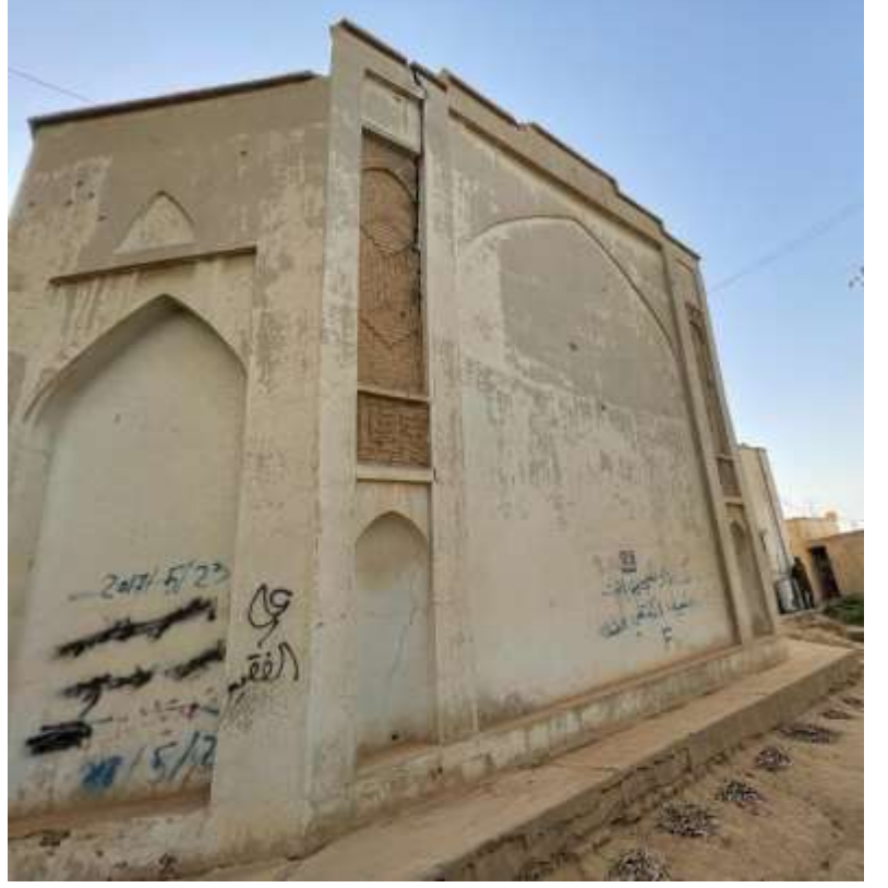
ملحق رقم (9) الواجهة الشرقية للمتحف
