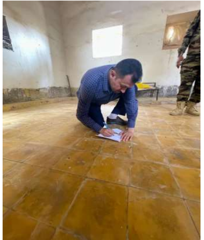
ملحق رقم (17) ارضية مبنى المتحف المبلطة بالكاشي (تصوير الباحث)
