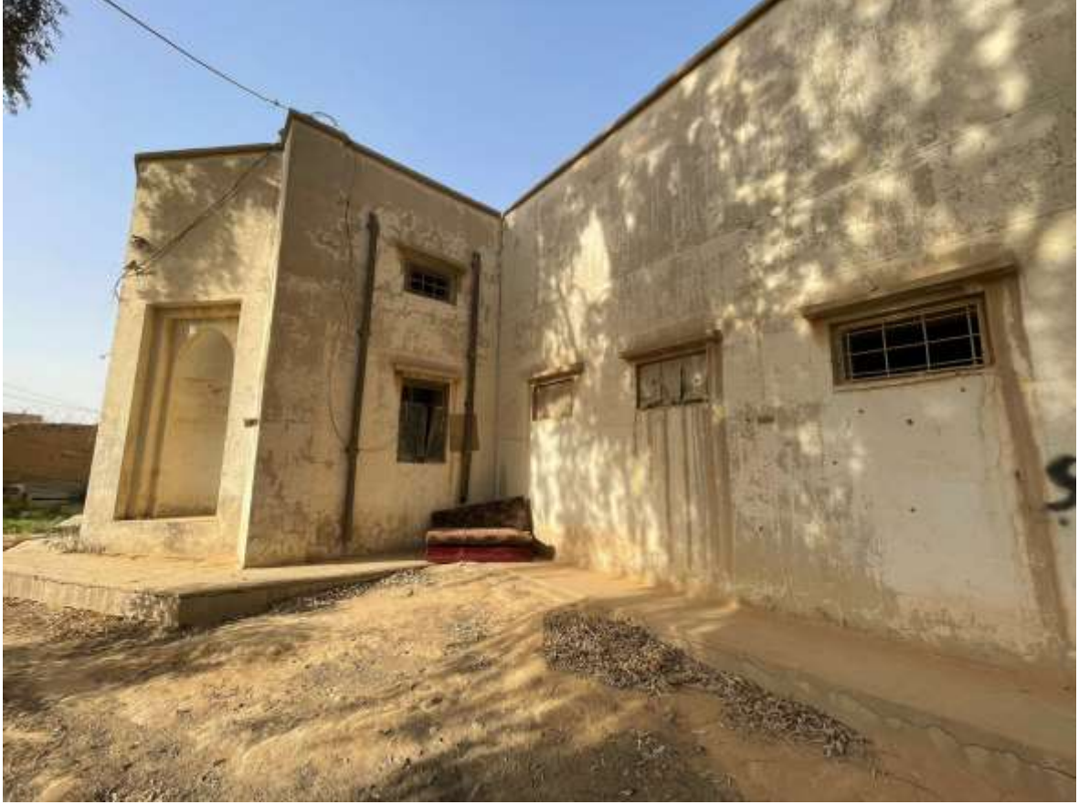
ملحق رقم (21) نوافذ في الجهة الجنوبية الغربية من مبنى المتحف (تصوير الباحث)
