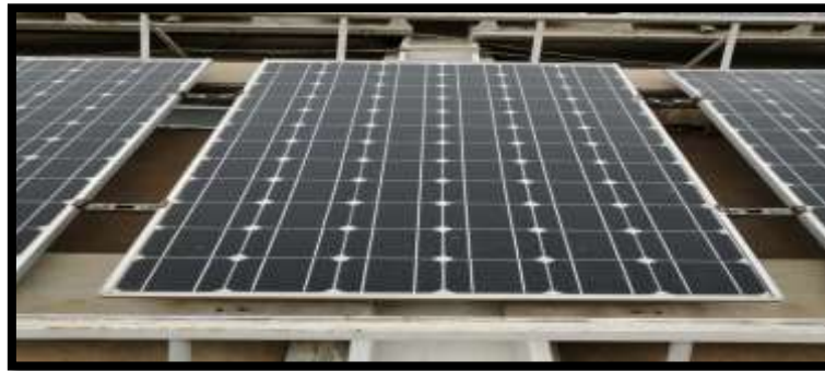
الشكل (4) اللوح الشمسي (Monocrystalline) PV بكفاءة (12%)
